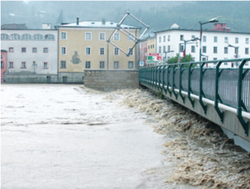
Im Jahr 2002 schlitterte Hallein gerade noch an einer Katastrophe vorbei. Es fehlte nicht viel, und der Fluss wäre bis ins Zentrum gedrungen. Jetzt kommen auch im Bereich der Altstadt Hochwasserschutz Baumaßnahmen.
